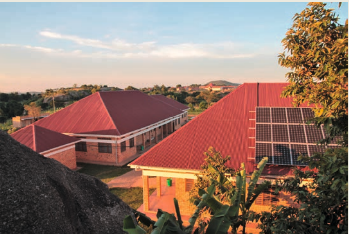
Regionalkrankenhaus Kooki, errichtet 2015 - 2018, ausgelegt für 120 Patienten/Tag in der Ambulanz, mit 30 Betten für stationäre Aufnahme, mit OP, Labor und Apotheke und eigenem Ambulanzfahrzeug.
